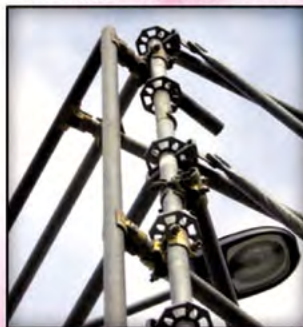
PONTEGGIO DI ISOLAMENTO
