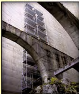
PONTEGGIO DI RESTAURO
