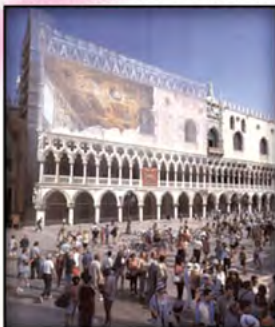
PONTEGGIO DI FACCIATA
